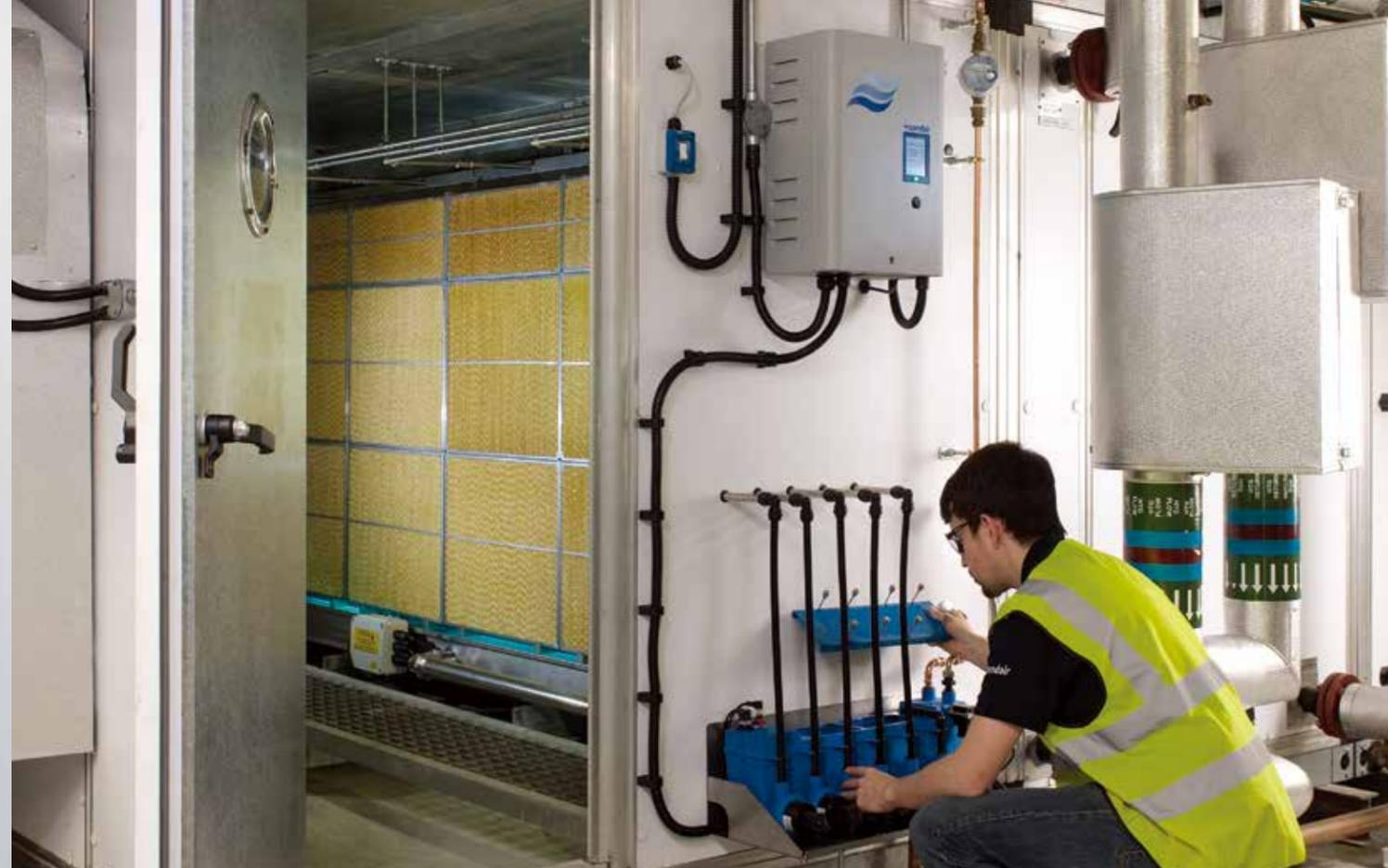
Condair ME Condair ME com unidade hidráulica montada no exterior
