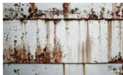
Prevención de la oxidación y la corrosión
